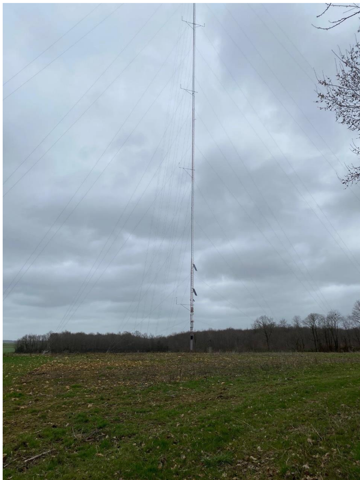
Illustration 6 : Mât de mesure installé sur la commune de Lizant
